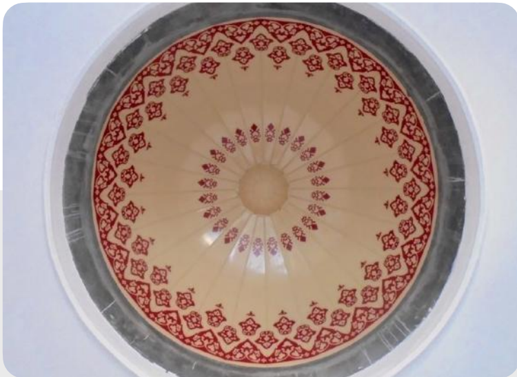
Kubah Plafond Dekoratif Mustaka Masjid SPBU Pelutan (2,5 Meter) - Pelutan, Pemalang, Jawa Tengah
