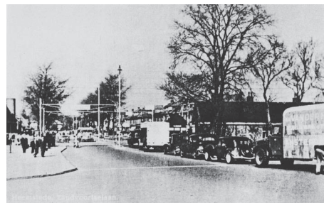
Verkeersopstoppingen bij de overweg.
