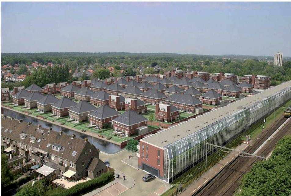
Nieuwbouwwijk "Het Vogelpark" van KOW Architecten.
