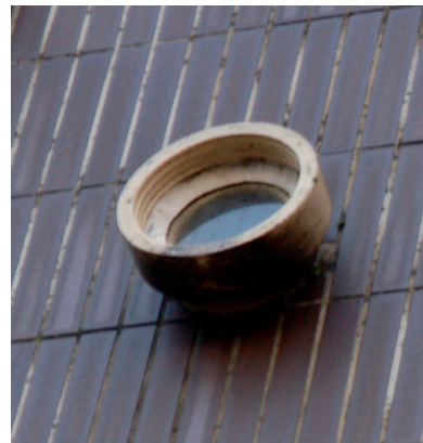
Gresbuis als raam in de gevel.
