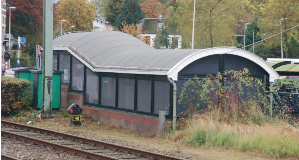
Overdekte entree van de zuidelijke perrontunnel bij de spoorovergang
