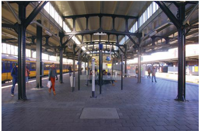
Constructie perronoverkapping Naarden-Bussum. Let op het ontbreken van de diagonalen en de momentvaste verbindingen
