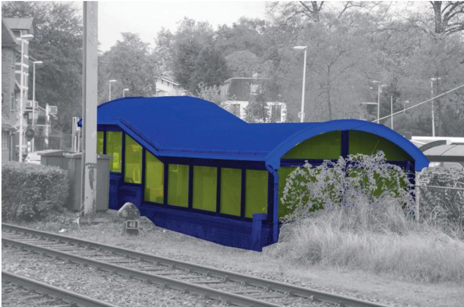
Waardering overkapping boven opgangen zuidelijke perrontunnel
