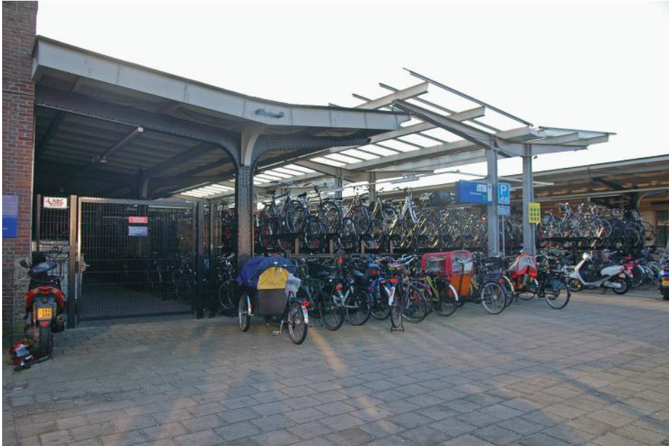
Perron-overkapping 'Gooische Tram Maatschappij'. Nu een fietsenstalling
