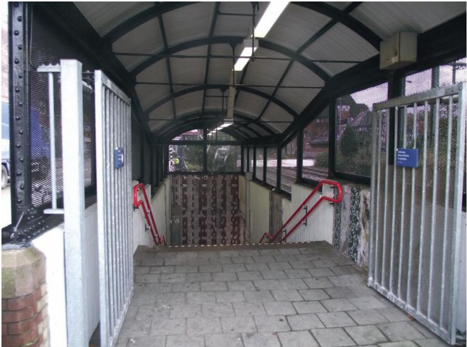
Entree van de zuidelijke perrontunnel
