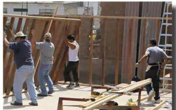
Construyendo una casa
