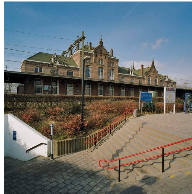
Trappartij vóór de toegang naar de voetgangerstunnel, 2004. [www.stationsweb.nl]
