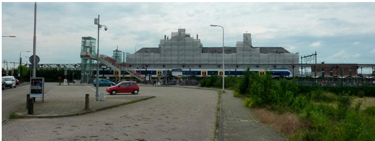
Stationscomplex gezien vanaf het parkeerterrein ten oosten van het emplacement. Links is de traverse gebouwd in 2010.
