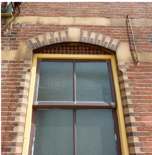
Siertegel- en metselwerk van het nevengebouw.
