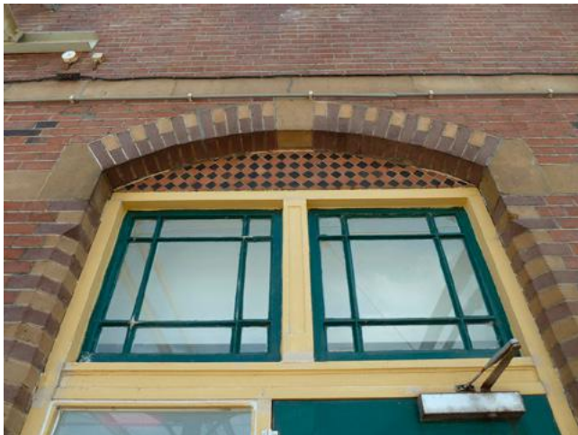
Oorspronkelijk siertegel- en metsenwerk (nevengebouw).
