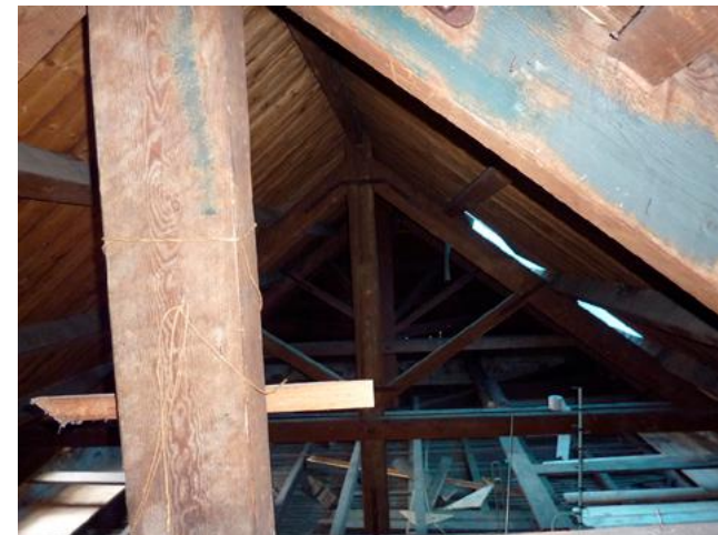
Dak en schoorstenen van het stationsgebouw. Kapconstructie ter plaatse van het voormalig plaatskaartenkantoor (nu Kiosk).
