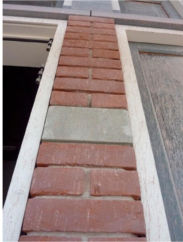
Herstel metselwerk en restauratie van het voegwerk.
