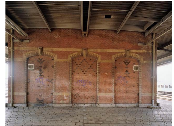
Noordgevel met oorspronkelijke blindnissen. Deze worden bij de huidige restauratie geopend. [ www.stationsweb.nl ]
