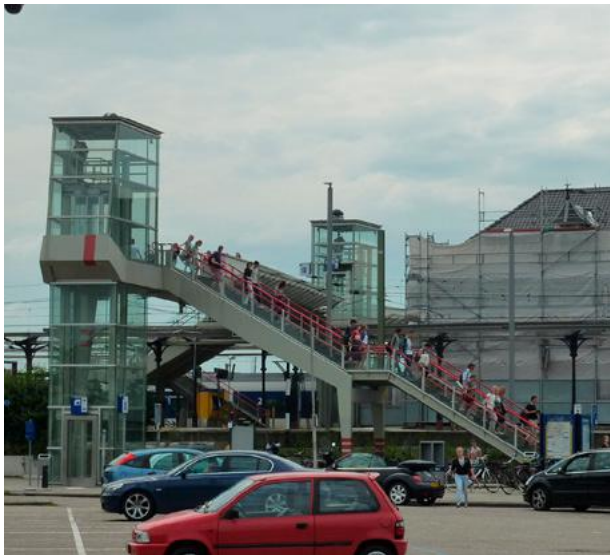
Liften en trappen van de huidige voetgangersbrug.
