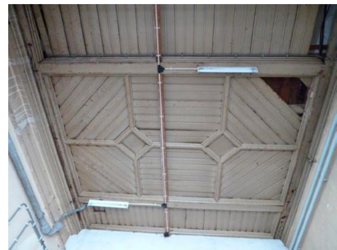
Plafond in de voormalige woning van de stationschef.
