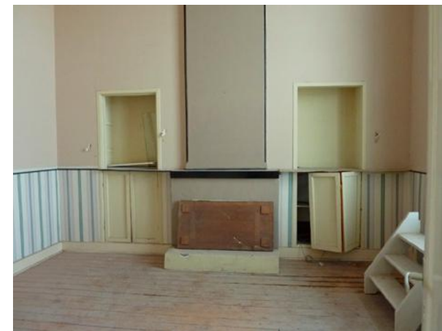
Interieur van de voormalige woning van de stationschef.
