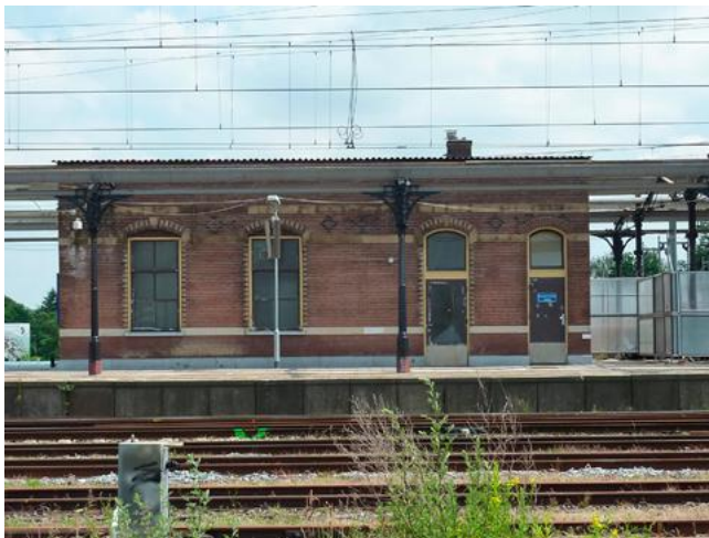
Nevengebouw, westgevel in huidige staat. De rechterdeur is niet origineel.
