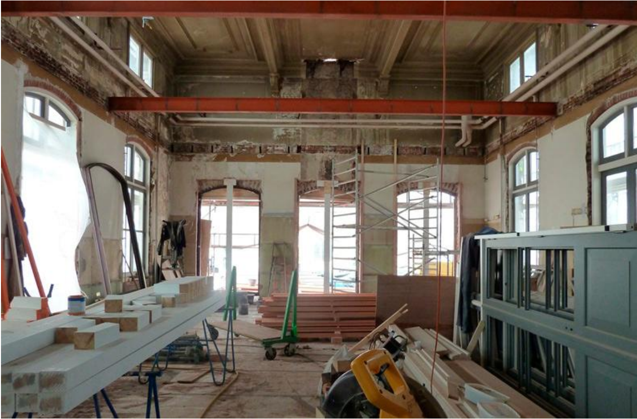
Voormalige wachtkamer derde klasse. De blindnissen aan de zuidkant zijn opengebroken. Onder andere het originele plafond is zichtbaar geworden.
