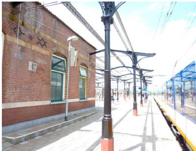
Nevengebouw, oostgevel in huidige staat.
