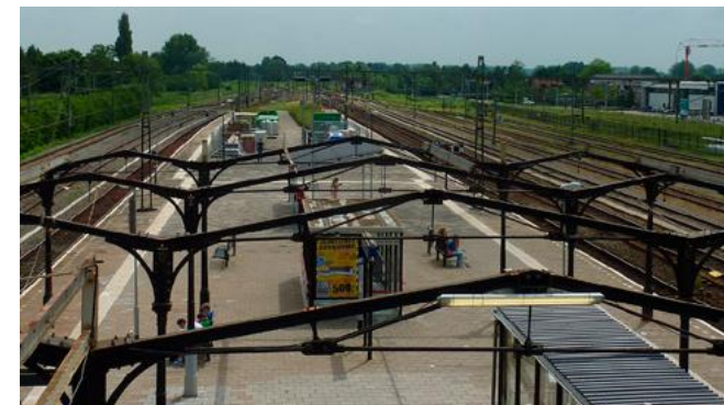
Perronoverkapping zonder dakbedekking, 2014.
