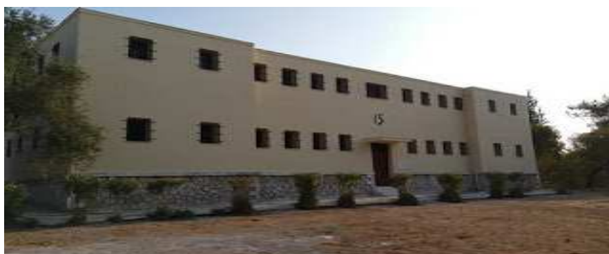
Το «Μπλοκ 15» σήμερα. Μετά τις επισκευές -Μπροστινή πλευρά 424 []
