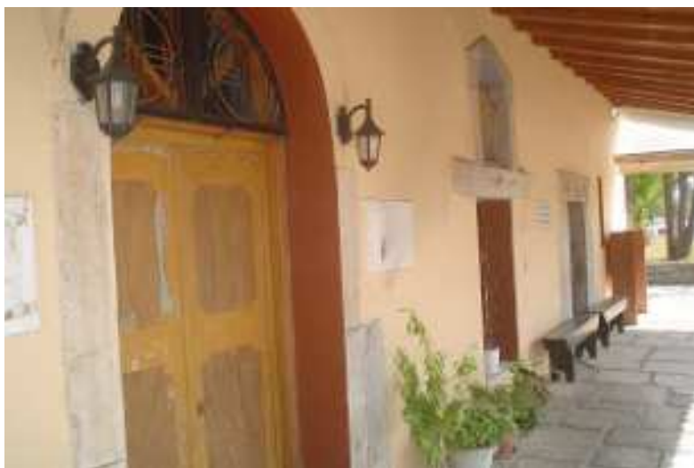
Στη μικρή εκκλησία του Αγίου Σάββα στο νότιο κράσπεδο της σημερινής οδού εντοιχισμένα αρχαία μάρμαρα φαίνεται να ανήκουν σε μνημεία της Ιεράς Οδού 217
