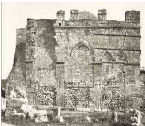
Η δυτική όψη του εξωνάρθηκα μετά την αποκατάσταση 87
