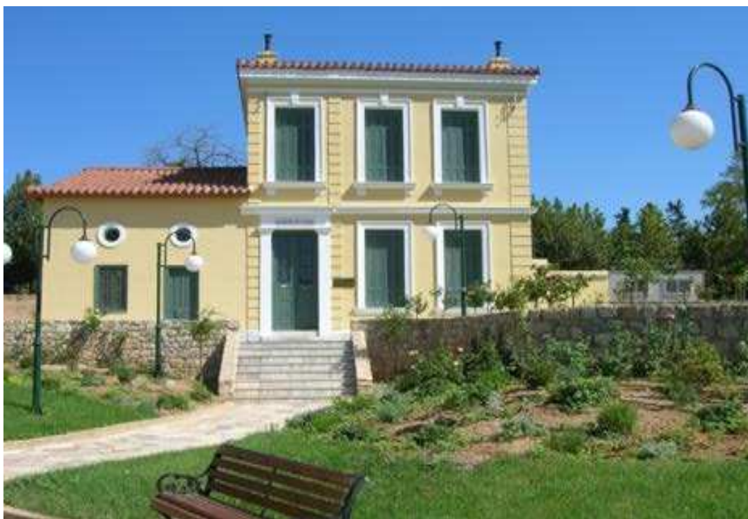
Κτίριο Ν. Γύζη. Μετά τις εργασίες αποκατάστασης και διαμόρφωσης του περιβάλλοντος χώρου 37
