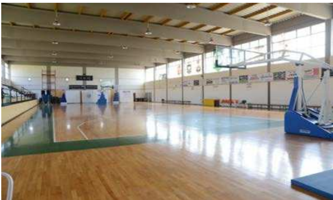
Άποψη του εσωτερικού χώρου του κλειστού Δημοτικού Γυμναστηρίου «Χρήστος Αγγουράκης» 350
