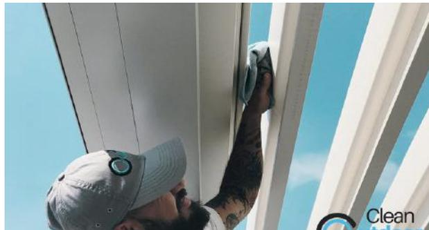
**Grondaie e discendenti:** da controllare periodicamente e pulire da fogliame e residui terrosi per evitare intasamenti. Giunti tra elementi: vanno controllati ed eventualmente puliti a garanzia di una durabilità-solidità della struttura.
