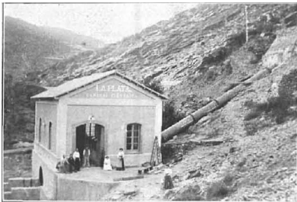
Central eléctrica de las minas
