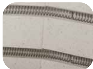
Éléments chauffants logés dans des gorges protectrices
