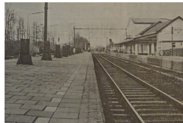
62. Restanten van kolommen na sloop, 1988. [Archief Nijkerk]
