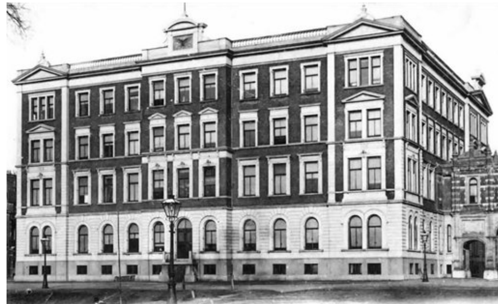
09. Eerste Administratiegebouw voor de Spoorwegen in Utrecht, 1870. [HUA]
