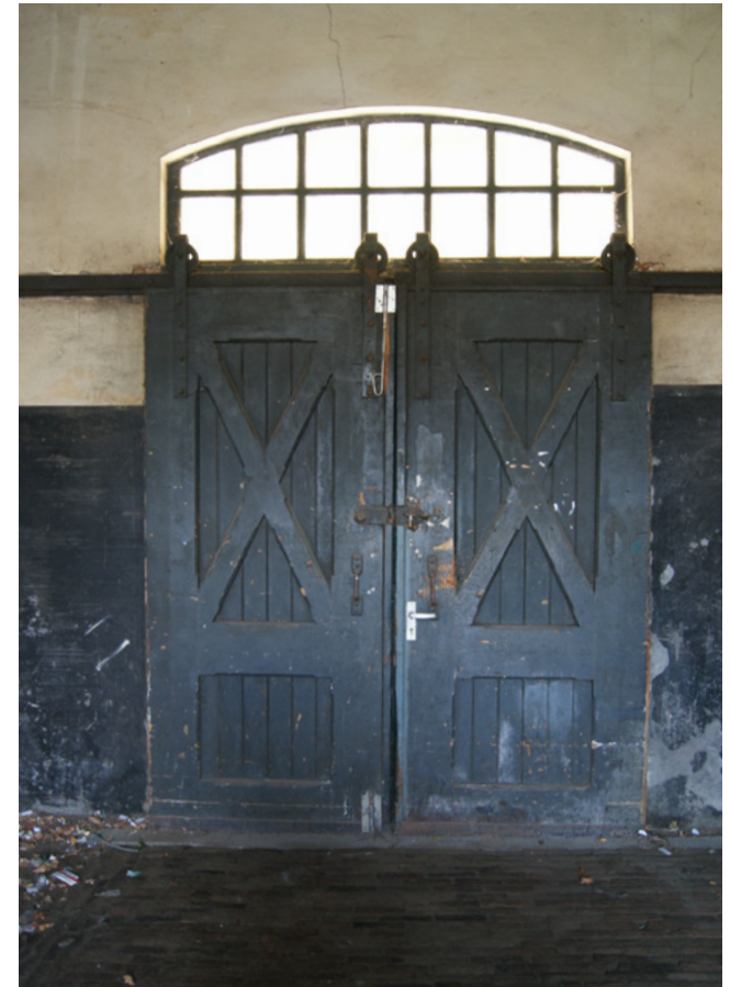
53. Grote roldeuren en een klinkeren vloer in voormalige loods.
