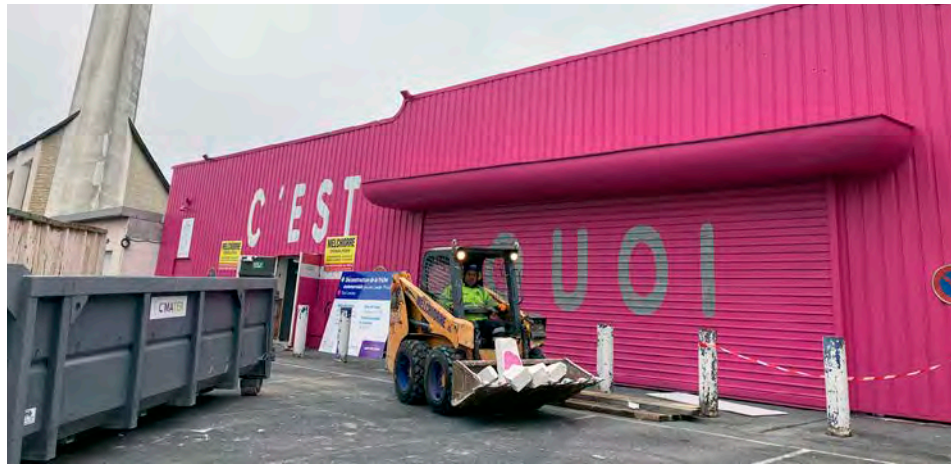
Le curage et la dépollution laisseront place à la démolition, fin février. © L'Hebdo du Vendredi
