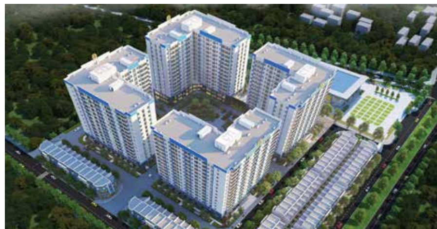
Công trình Tòa CT1 thuộc Dự án Nhà ở thuộc quy hoạch khu thiết chế công đoàn tỉnh Bình Định
