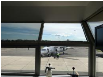
Teintage des fenêtres pour minimiser les pertes de chaleur (Source: DTE)
