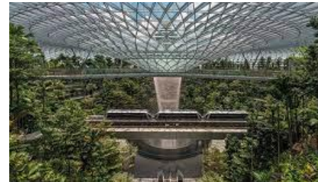
Architecture d'aéroport écologique : l'aéroport de Changi (Source: Mercator Airport-World)
