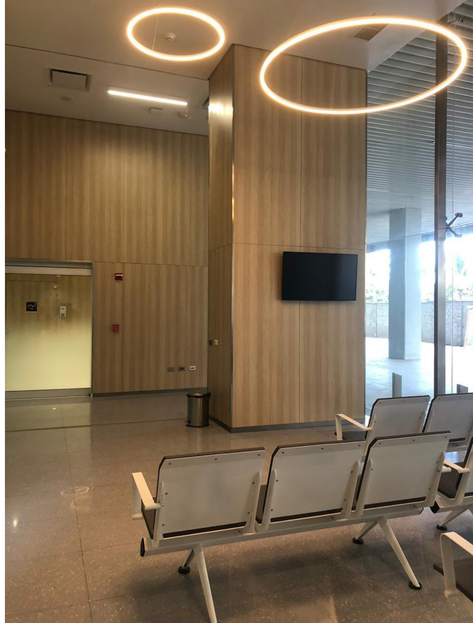
Panama Clinic REVESTIMIENTO HPL EN CUARTOS DE EMERGENCIA Y AREAS COMUNES
