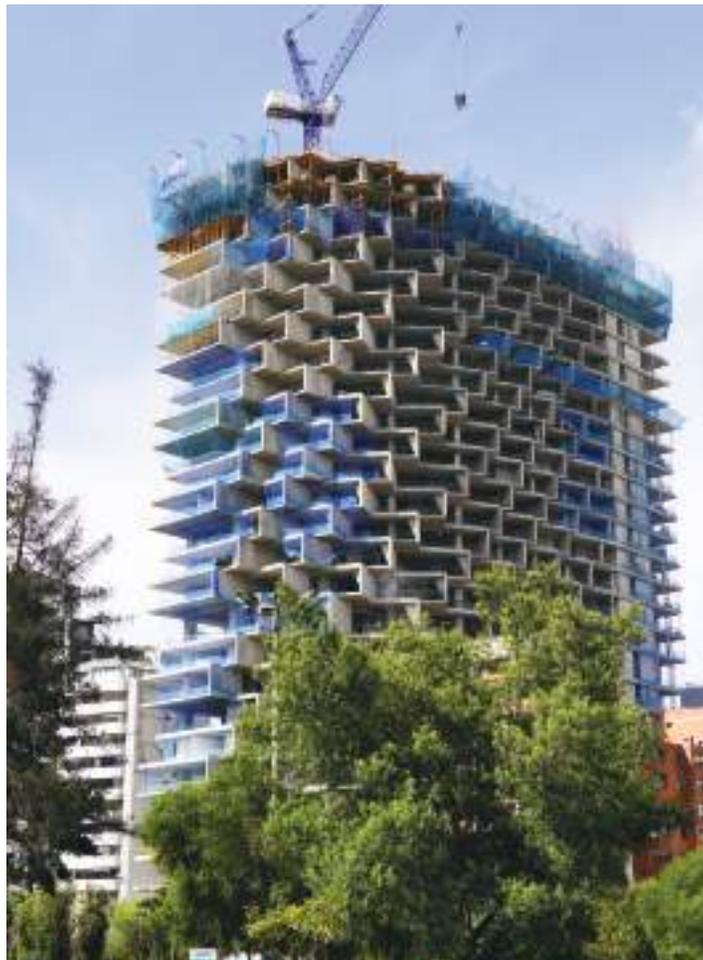
Fig. 6: La grúa de construcción estuvo apoyada en los pisos ya terminados (fotos cortesía de Uribe Schwarzkopf).
