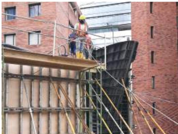
Fig. 7: El encofrado de acero se reutilizó para construir las jardineras de las terrazas (foto cortesía de Fernando Romo Consultores).
