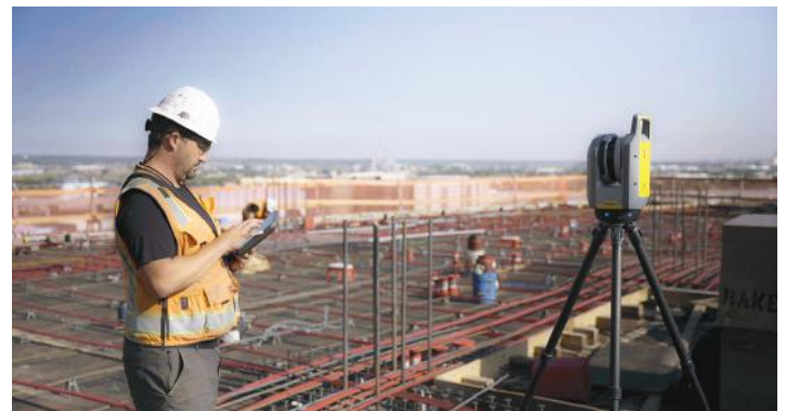
Un escáner láser tridimensional (3D) de alta velocidad Trimble X7 está siendo utilizado para identificar problemas antes de la colocación del concreto, lo que permite acelerar los flujos de trabajo y garantizar una precisión milimétrica. (Fotografía cortesía de Trimble)
