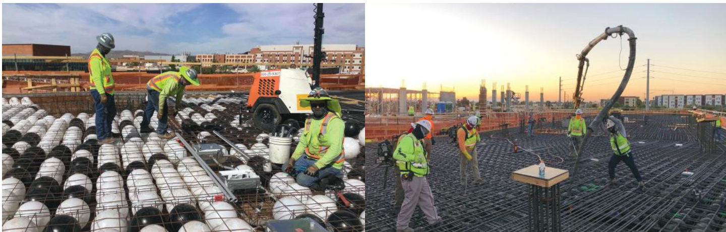
Fig. 3: La instalación con cimbra hueca y colocación de concreto para la base elevada (cortesía de McCarthy Building Companies)
