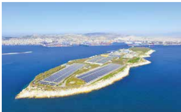
Κέντρο Επεξεργασίας Λυμάτων Ψυττάλειας. Πηγή: Αρχείο ΕΥΔΑΠ.
