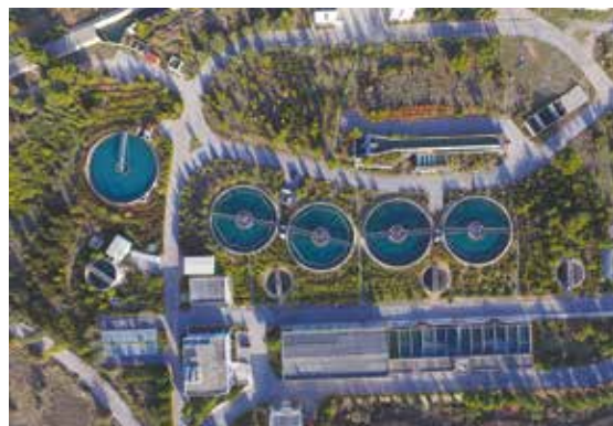
Μονάδα Επεξεργασίας Νερού Ασπροπύργου. Πηγή: Αρχείο ΕΥΔΑΠ.
