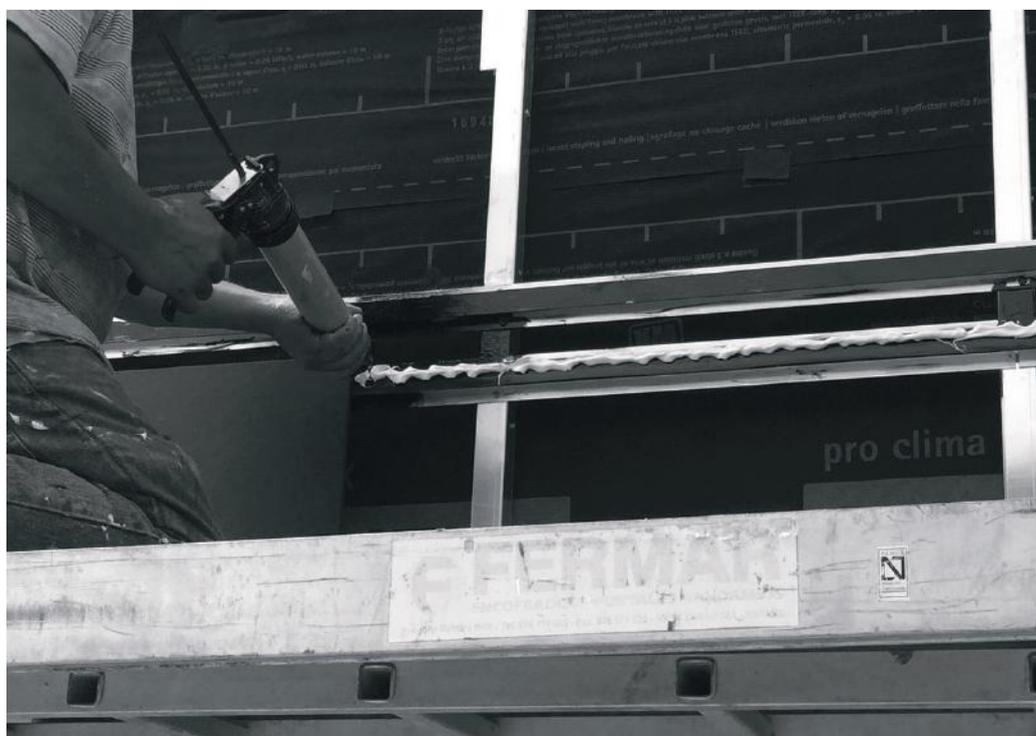
Fijación con anclaje químico sobre perfilería.
