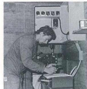
Das eigene Kraftwerklein von 14,5 kW Leistung wird durch Thomas Sidler als angehender Elektromonteur während des «Einlaufs» stündlich auf seine Funktionstüchtigkeit überprüft.
