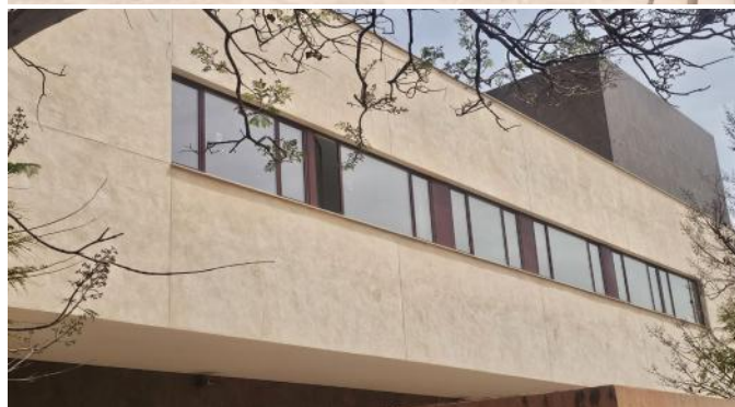
Teatro Municipal de ALHAURÍN DE LA TORRE. Para este proyecto se han instalado los sistemas ALUPROM 36 y 31 .
