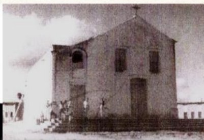
MESMA CAPELA NO INÍCIO DE SUA DEMOLIÇÃO
