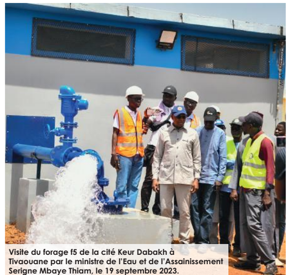
Accompagné d'une forte délégation dont le gouverneur de la région de Thiès, le ministre de l'Eau et de l'Assainissement Serigne Mbaye Thiam s'est rendu le 19 septembre 2023 à Tivaouane pour visiter les chantiers portés au niveau du Bassin exutoire du réseau d'eaux pluviales de Pam.
