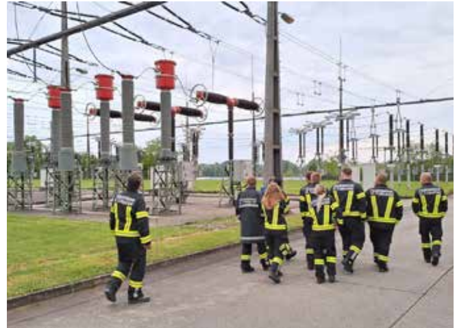
Begehung vom Kraftwerk
