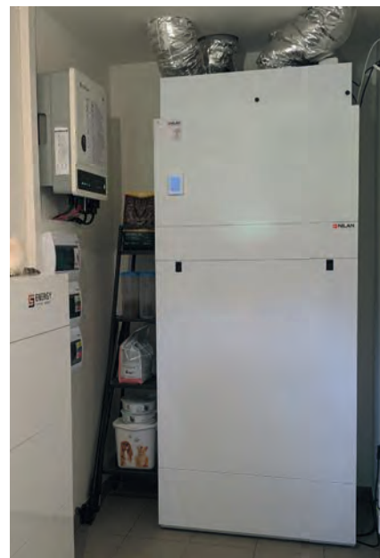
Instalace komplexní jednotky Nilan Compact K AIR9
