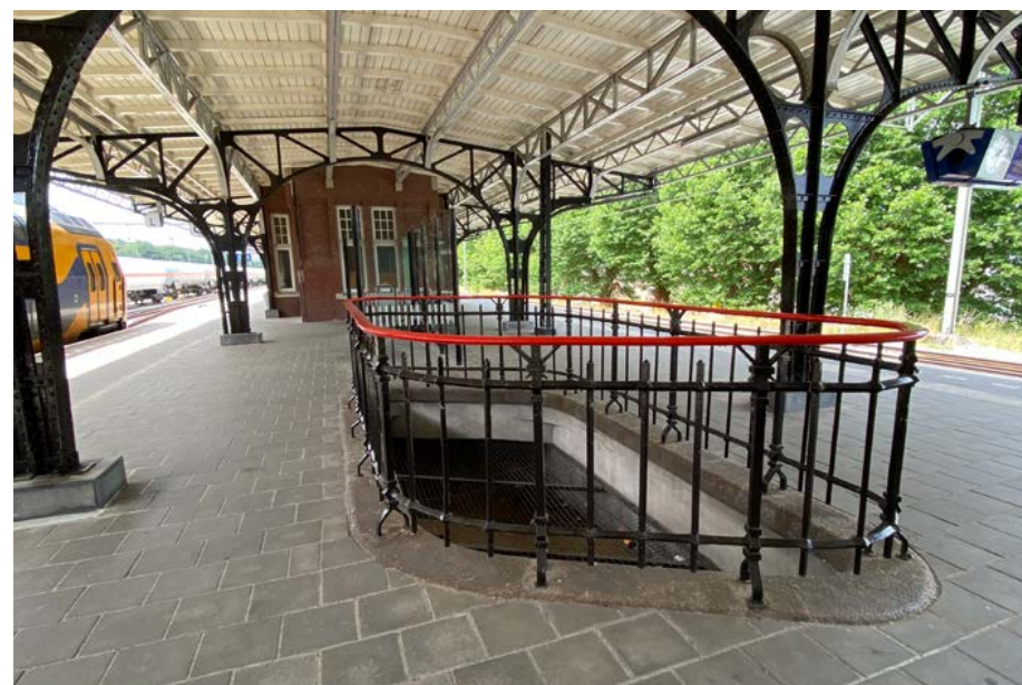
Oorspronkelijk hekwerk rondom de lichtschacht van de spooronderdoorgang [Eigen collectie].
