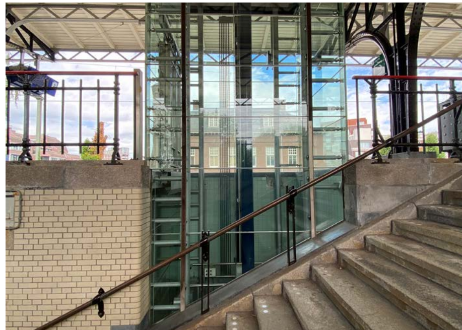
Snede in de wand van het trappenhuis t.b.v. de personenlift [Eigen collectie].
