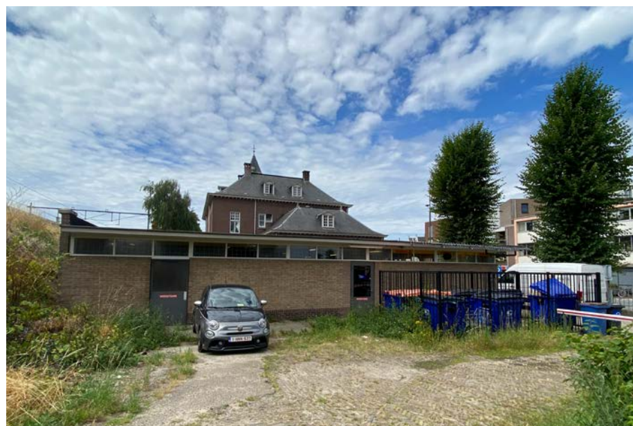
Zicht op de oostgevel van de fietsenstalling [Eigen collectie].
