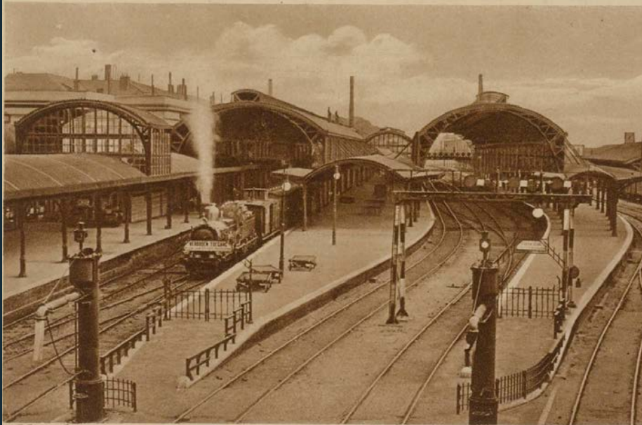
Het ontwerp voor de driedelige overkapping van station Utrecht (1893 - 1895) is een van de eerste zelfstandige projecten van Van Heukelom. Foto uit 1915, [GVN].
