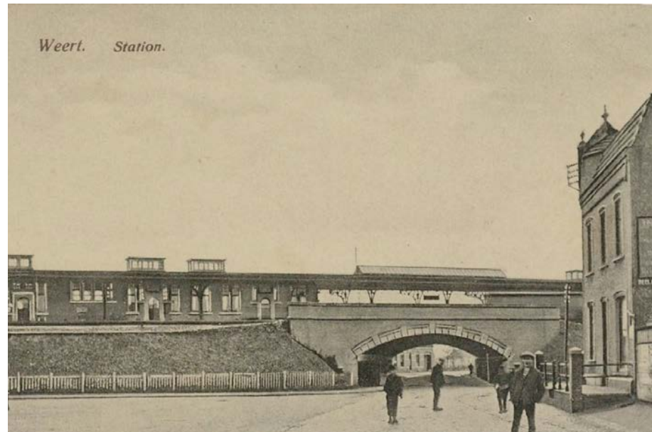
Zicht vanuit de Stationsstraat op de spooronderdoorgang met het daarbovenuitrijzende perroneiland met overkapping en perrongebouwen, 1915 [GVN].
