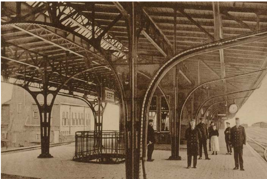
De perronoverkapping ter plaatse van de lichtschaft van de spooronderdoorgang. Op de achtergrond is links het stationsgebouw te zien, 1915 [GVN].
