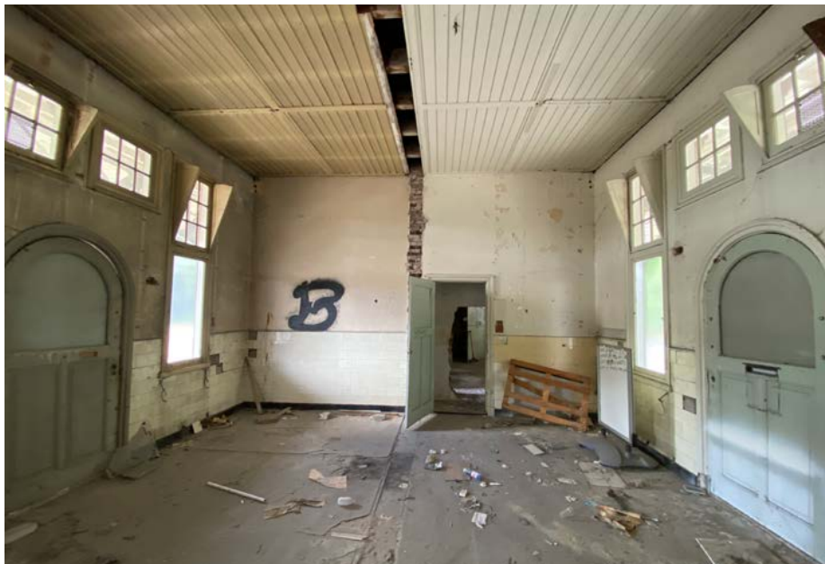
Het dienstgebouw verkeerd intern in slechte staat van onderhoud. Toch zijn er nog verschillende oorspronkelijke afwerkingen te vinden - zoals de houten kraaldelenplafonds, oorspronkelijke houten paneeldeuren en valramen. [Eigen collectie].
