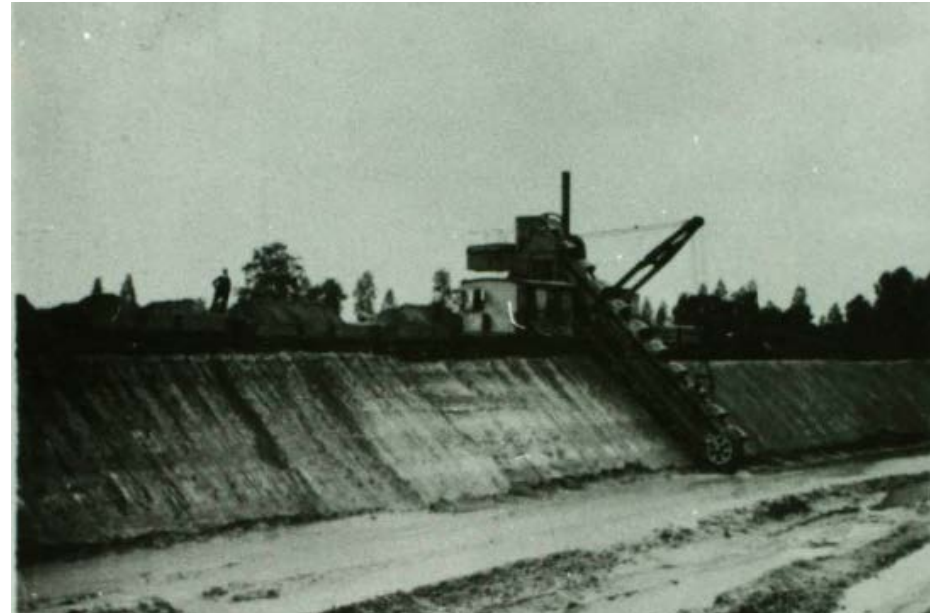
Aanleg spoordijk bij Weert d.m.v. "de IJzeren Man", 1911, [GAW].
