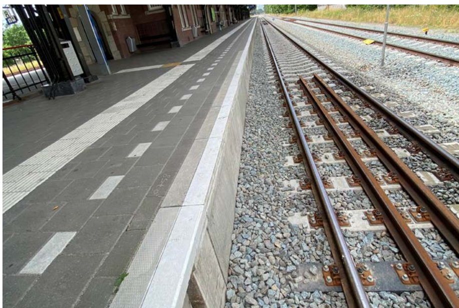
Huidige perronafwerking - betontegels en betonnen beplating perronwand [Eigen collectie].
