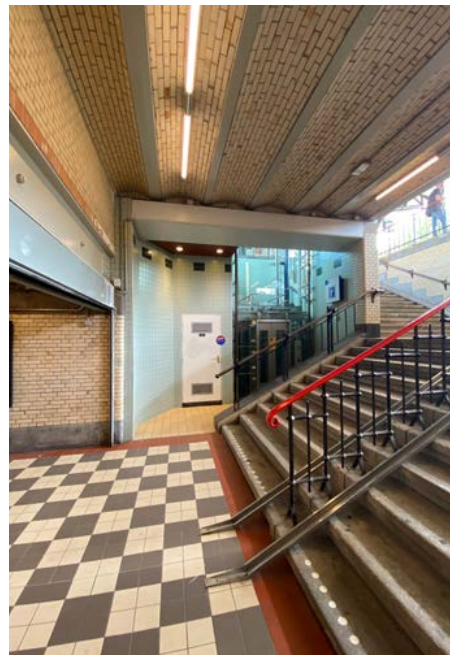
Trappenhuis met oorspronkelijke afwerking en ingepaste personenlift [Eigen collectie].
