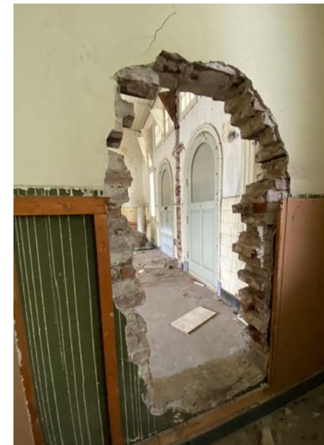
Het dienstgebouw verkeerd intern in slechte staat van onderhoud. Toch zijn er nog verschillende oorspronkelijke afwerkingen te vinden - zoals de houten kraaldelenplafonds, oorspronkelijke houten paneeldeuren en valramen. [Eigen collectie].
