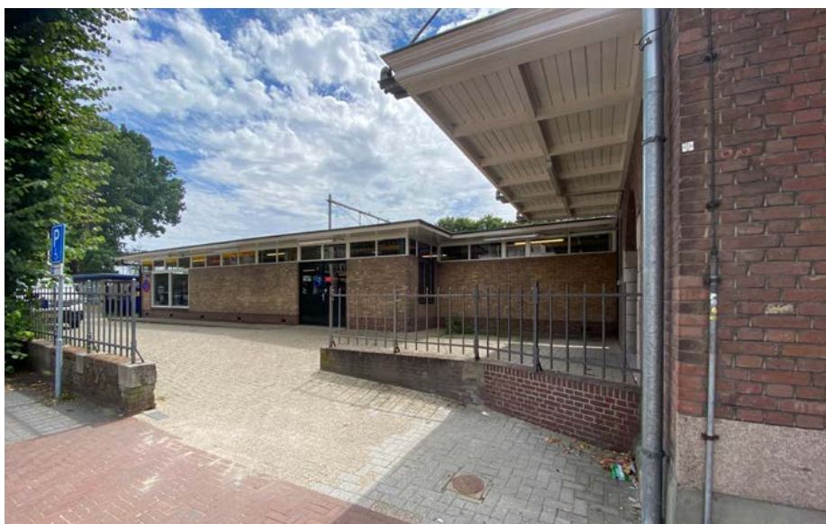
Zicht op de iets terug gelegen noordgevel van de fietsenstalling en keerwand met smeed-ijzeren hekwerk [Eigen collectie].
