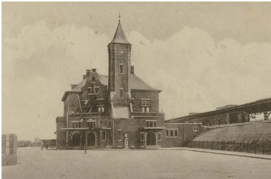
Voorgevel van het stationsgebouw met daarachter het verhoogde perroneiland met perronoverkapping en -gebouwen, 1915 [GVN].
