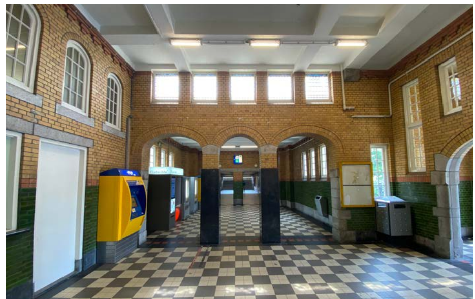
Doorgang richting de voetgangerstunnel met zicht op de later aangebrachte zwarte beplating van de kolommen en een recente nieuwe invulling van de doorgang (links) [Eigen collectie].
