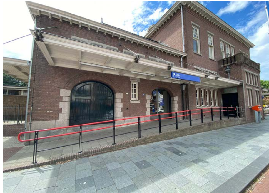
Gevel van de dienstvleugel met later geplaatste hellingbaan [Eigen collectie].
