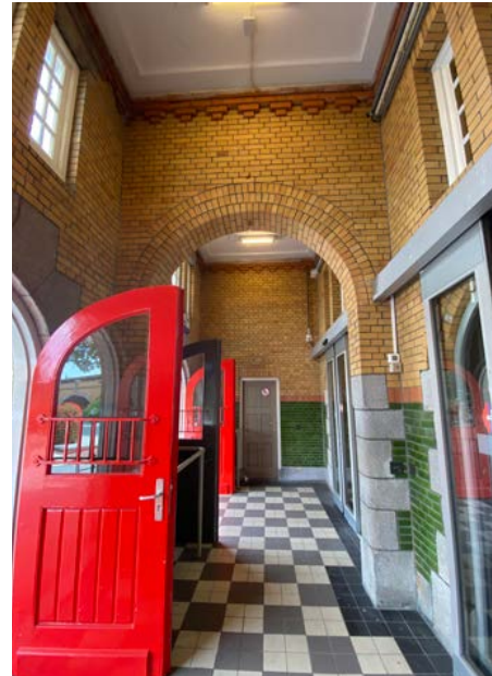
De automatische deuren en de recentere vloerafwerking doen afbreuk aan de rijk gedecoreerde afwerking van het tochtportaal van de hoofdentree [Eigen collectie].
