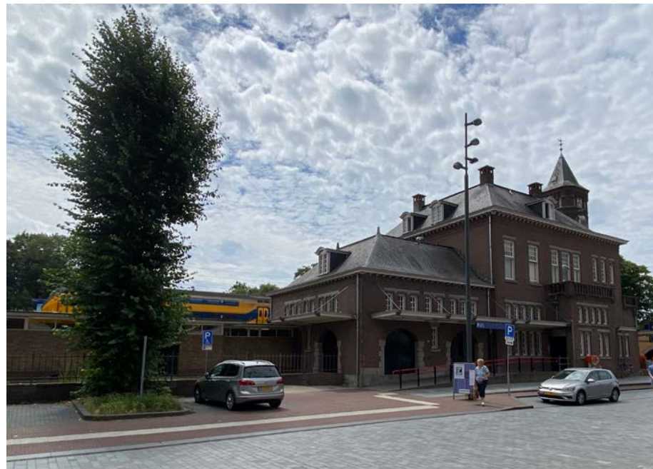
Zicht op de noordgevel met links de aangebouwde fietsenstalling [Eigen collectie].
