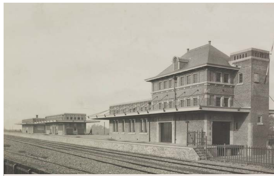
Achtergevel van station Maarheeze met perron en perrongebouwen, 1914. De perronoverkapping is hier opgehangen aan de gebouwgevels [GVN].
