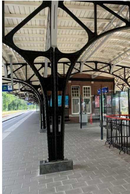
Perrongebouwen als onderdeel van de constructie van de perronoverkapping [Eigen collectie].
