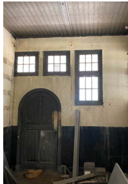
Het dienstgebouw verkeerd intern in slechte staat van onderhoud. Toch zijn er nog verschillende oorspronkelijke afwerkingen te vinden - zoals de houten kraaldelenplafonds, oorspronkelijke houten paneeldeuren en valramen. [Eigen collectie].
