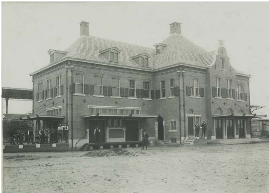
Voorgevel van station Geldrop met daarachter een verhoogd eilandperron, 1914 [GVN].
