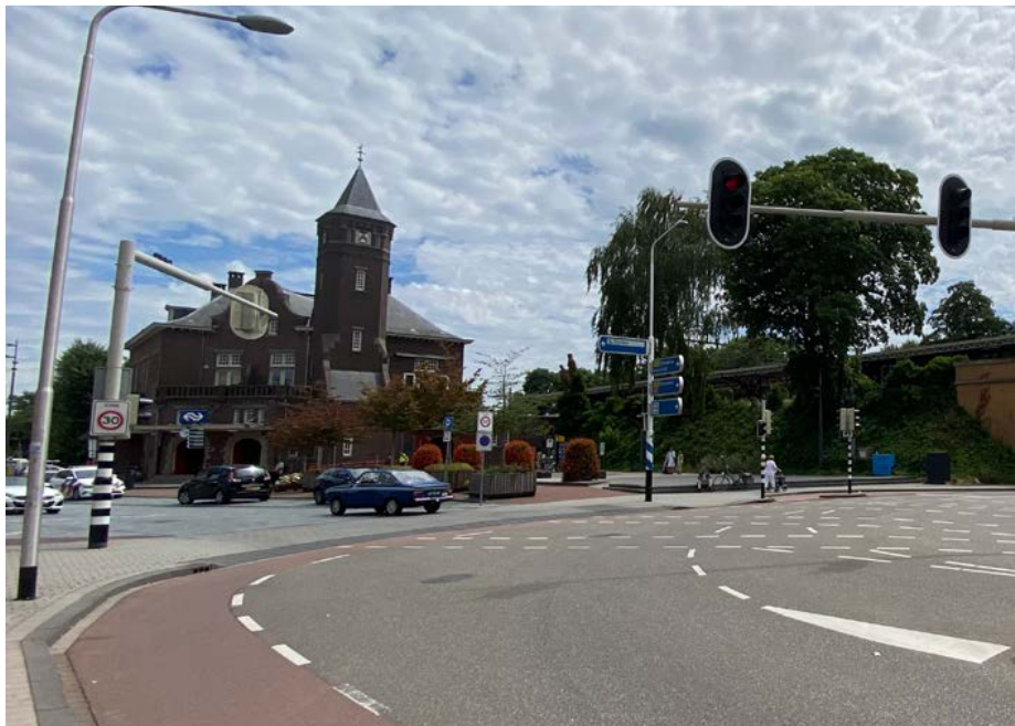
Zicht op het Stationsplein en de spooronderdoorgang vanaf de Parallelweg. [Eigen collectie].
