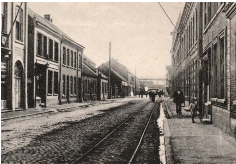
Zicht vanuit de Stationsstraat op de spooronderdoorgang, 1916 [GAW].
