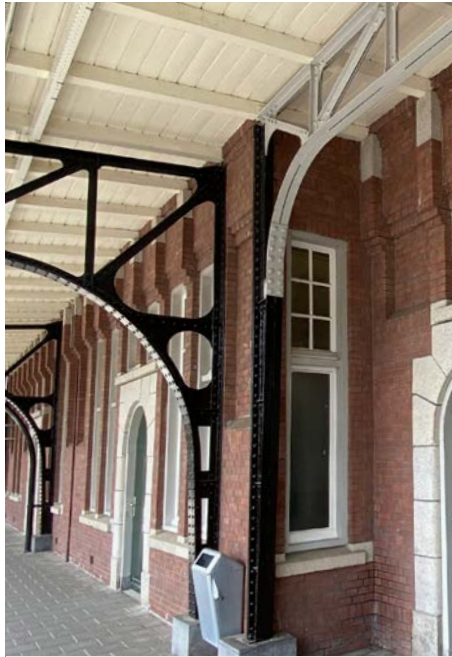
Perrongebouwen als onderdeel van de constructie van de perronoverkapping [Eigen collectie].
