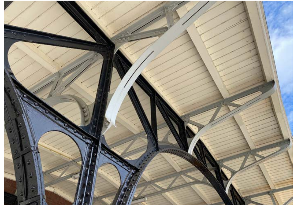
Geklinknagelde constructie met flauw hellend houten beschot [Eigen collectie].
