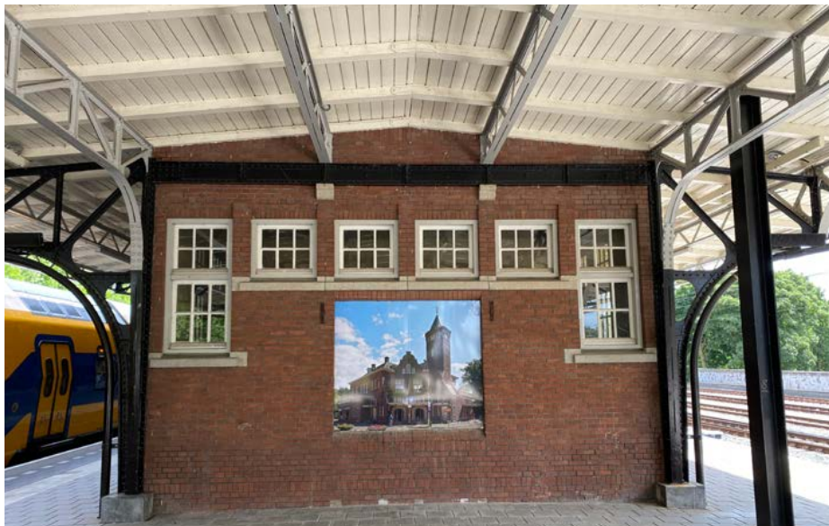
Kopgevel van het dienstgebouw (meest westelijke gebouw). Het oorspronkelijke rood-paarse tegeltableau is hier achter de fotoposter verdwenen. [Eigen collectie].
