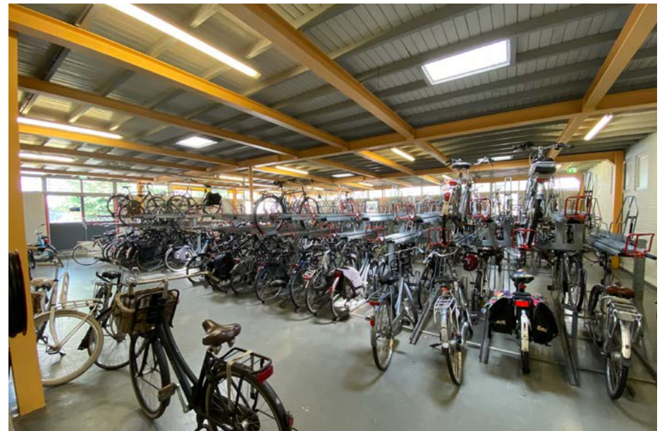
Tweede uitbreiding rijwielstalling uit 1959 [Eigen collectie].
