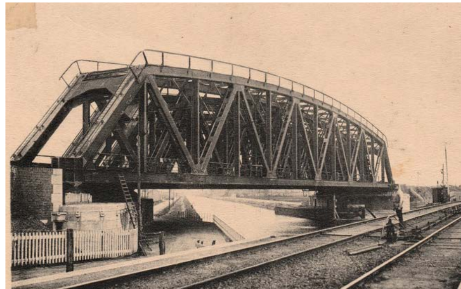
Aanleg van vier hoge nieuwe spoorbruggen over de Zuid-Willemsvaart met ervoor nog de oude draaibrug, 1913, [NW].
