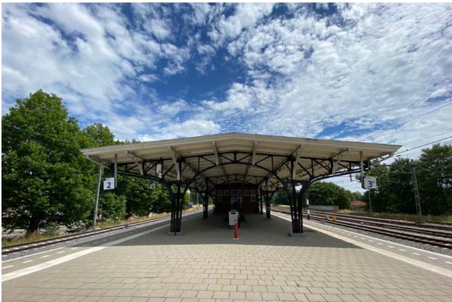
Zicht op de westelijke beëindiging van de overkapping [Eigen collectie].
