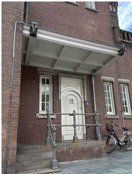
Entreepartij met oorspronkelijk bordes, hekwerken en detaillering [Eigen collectie].
