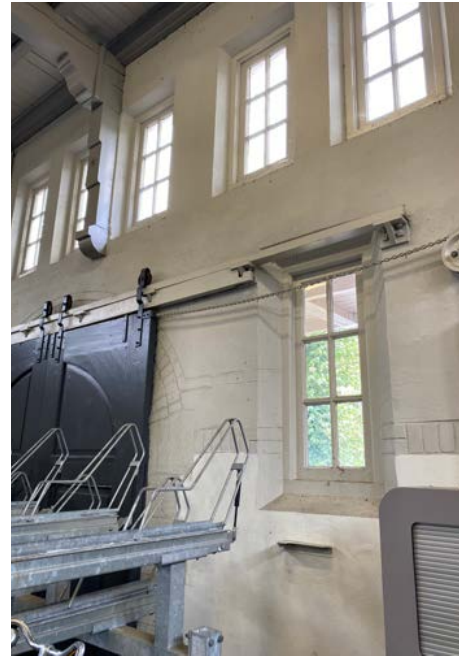
Oorspronkelijke houten schuifpui met loopwerk en spiltrap naar de vloering [Eigen collectie].
