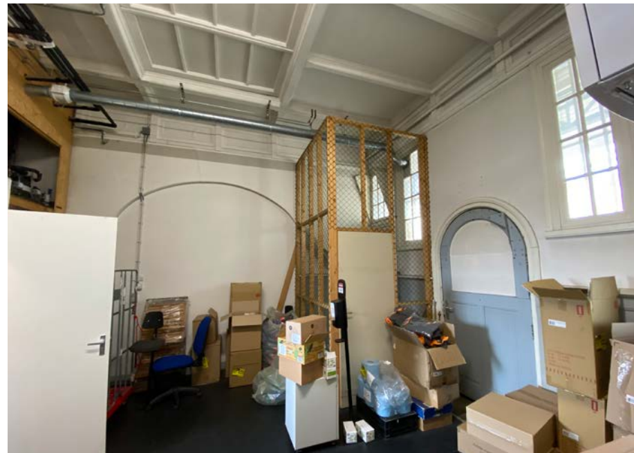
Plafondafwerking en dichtgezette boog in de voormalige wachtkamer 3e klas [Eigen collectie].
