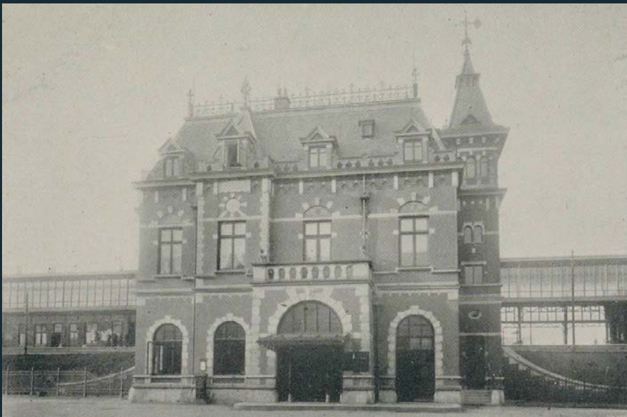
Het omvangrijke project voor station Hengelo was het eerste volledig zelfstandig uitgevoerde stationscomplex van Van Heukelom als Ingenieur - Architect. Foto uit 1905, [GVN].
