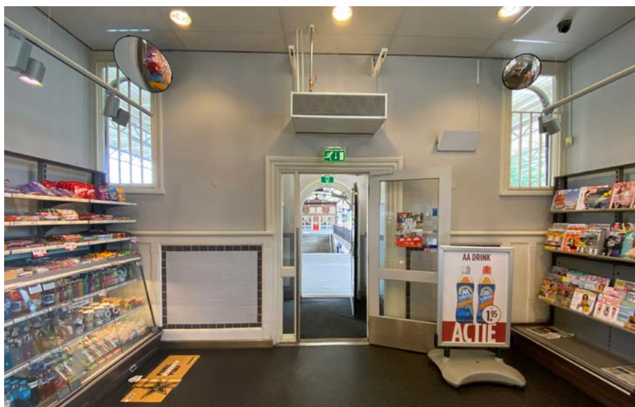
Inrichting van de Kiosk met oorspronkelijke lambrisering en deurlijsten met recente tegelinvulling [Eigen collectie].
